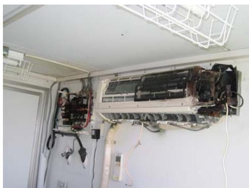
地中に埋設した同軸ケーブルの覆土が吹き飛んだ。シェルター内の壊れた配電盤(左)空調(右)
