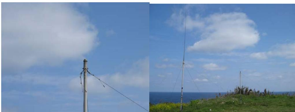
右側の送信アンテナのアンテナ部分が消失。送信アンテナ基柱の上にアンテナ素子があった
