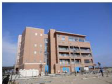
レンズ風車の設置予定建造物、宮城県亶理町
