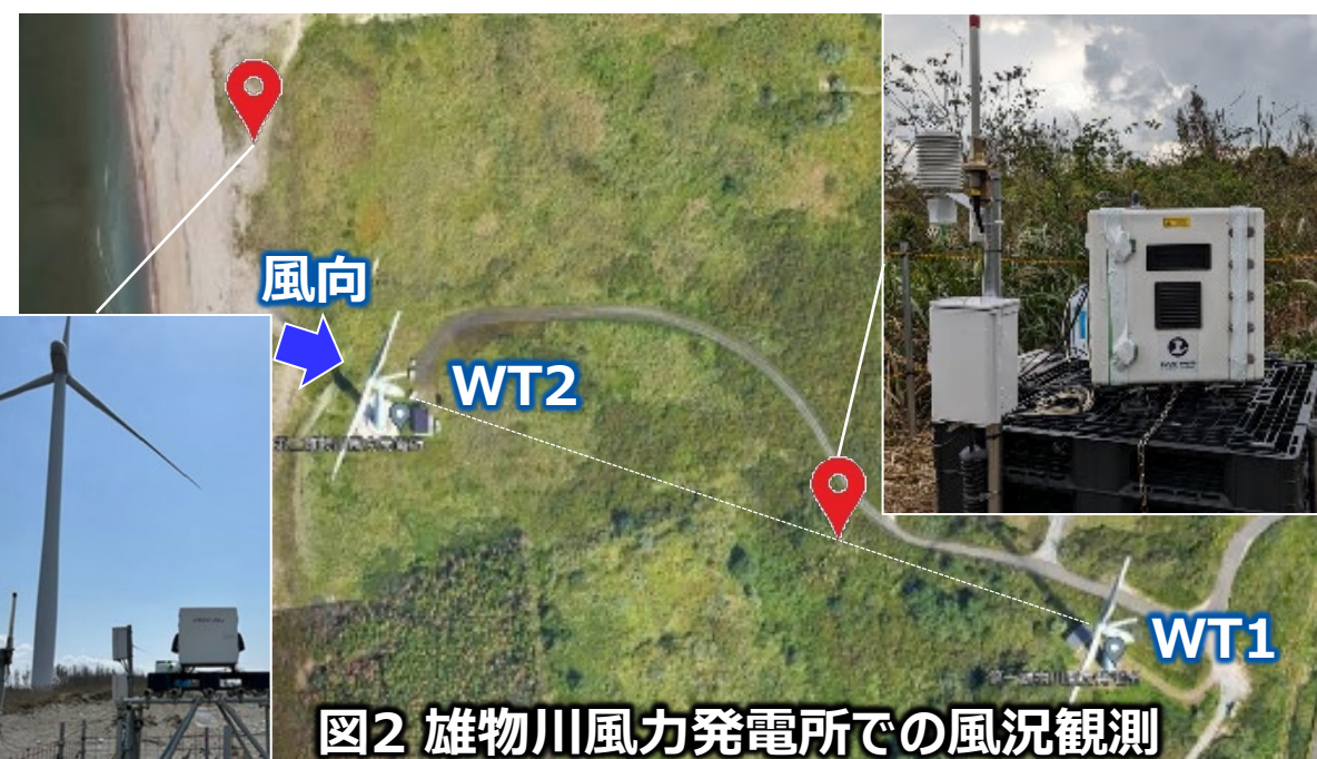
図2 雄物川風力発電所での風況観測
