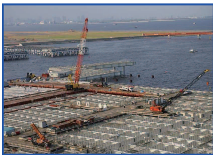
ジャケット据付
