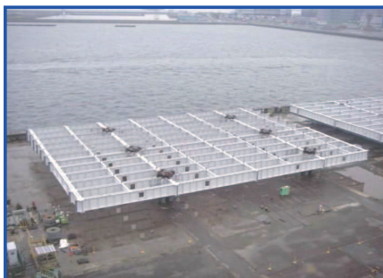
棧橋上部工製作
