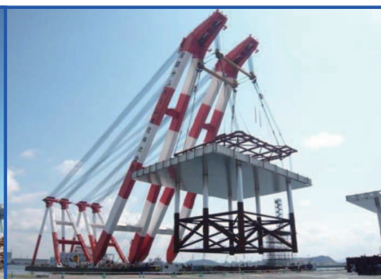
ジャケット完成・現地輸送
