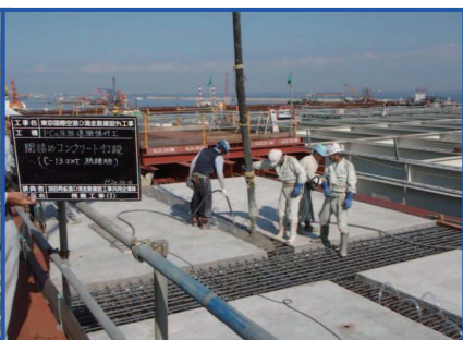
プレキャスト床版工
