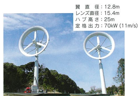
図14 九州大学伊都キャンパスに設置された 70kWレンズ風車2基、著者が2011年3月18日に撮影
