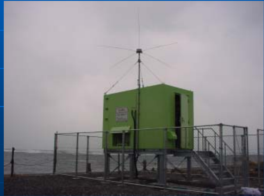
受信アンテナおよび 送受信機器用シェルター
