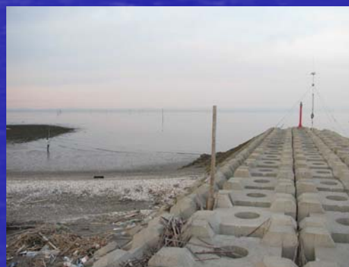
アンテナ設置状況
