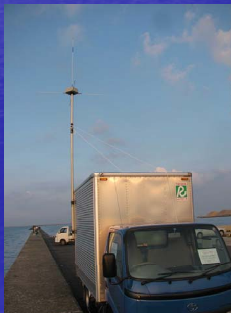
アンテナ設置状況
