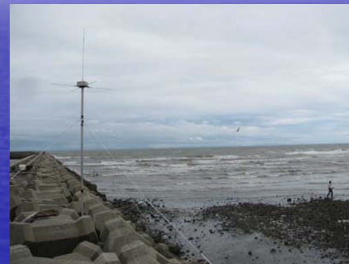
アンテナ設置状況
