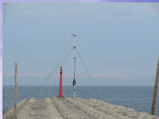
アンテナ設置状況 (吉富漁港局)
