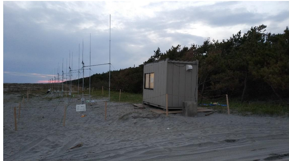
設置したアレイアンテナ
