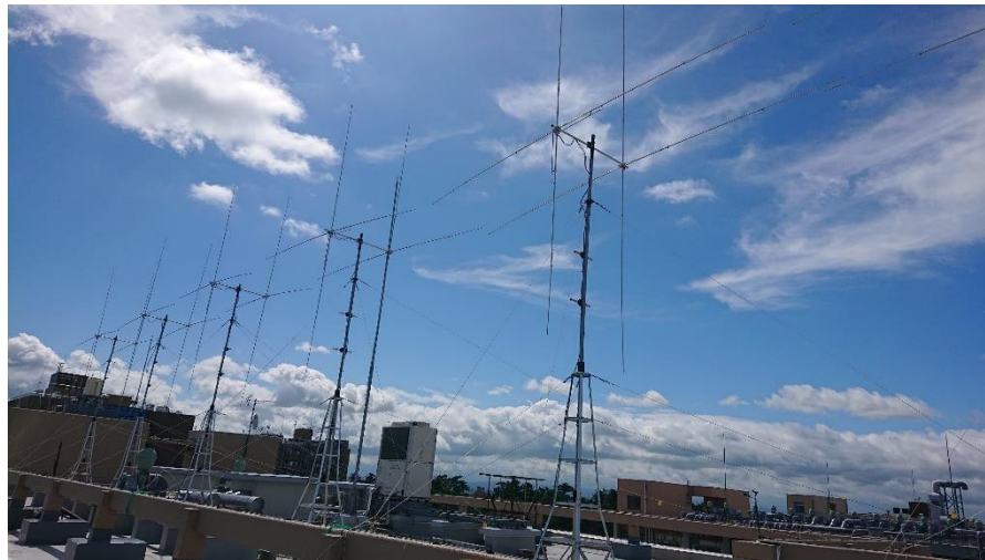
海洋レーダ at 新潟大学工学部棟屋上
