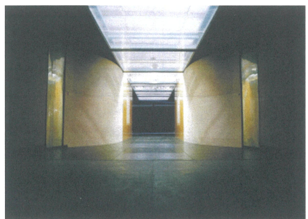
測定洞に設置した第2縮流洞
