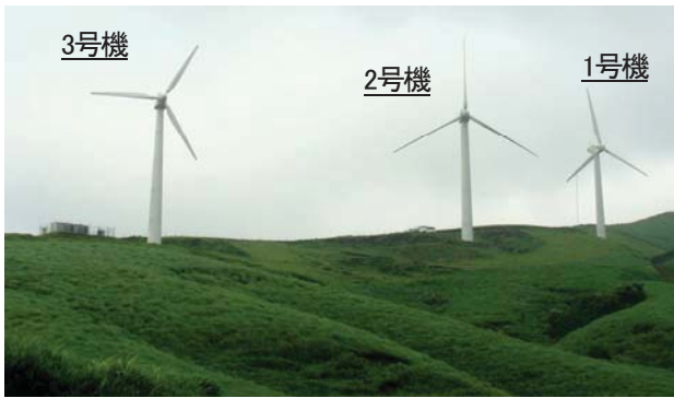
図-3 現場の写真(著者が2008年7月4日に撮影) 備考:風車ハブ高さの気流に対して、植生による地表面粗度の影響はほとんど無く、地形の凹凸の影響が支配的。
